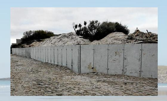
Face à l'érosion, des protections en dur : plaques de béton installées après les tempêtes de 2014 ou enrochements.
