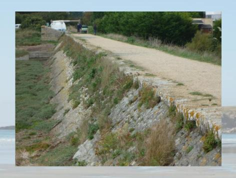
Digue construite en 1850 permettant de créer un polder sur le Ster Kerdour et de valoriser le milieu à des fins agricoles (champs de carottes).
