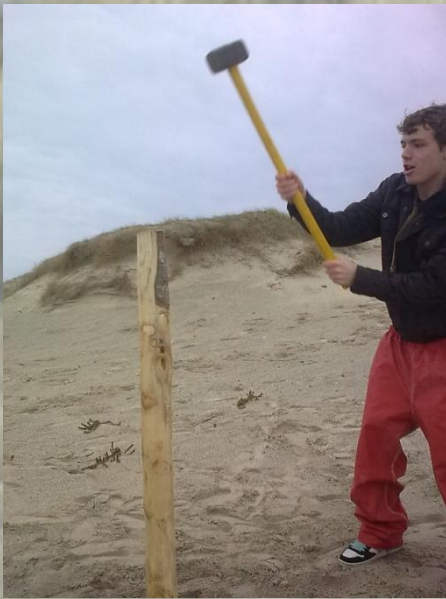
Deuxième étape : l'installation et l'enfoncement des poteaux
