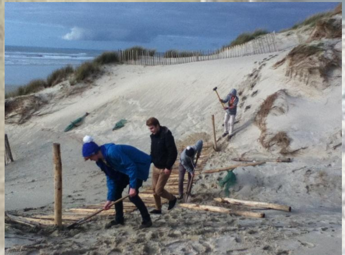
Installation des poteaux réalisée par le groupe de surfeurs de l'année 2012-2013
