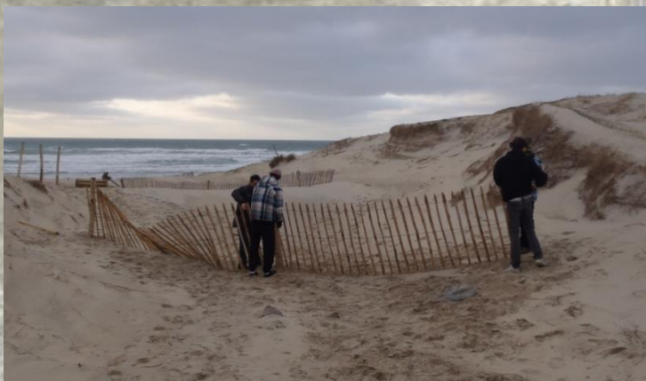
Troisième étape : la pose des ganivelles entre les poteaux. Les piétons ne pourront plus s'aventurer dans la brèche du cordon dunaire.
