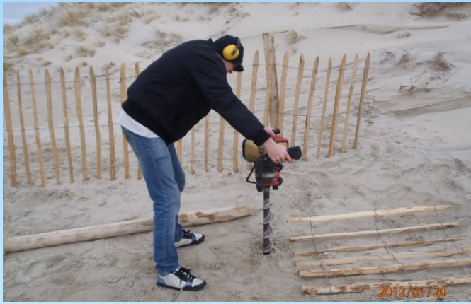
Première étape : creusement de trous, à l'aide de tarières, pour y enfoncer solidement les poteaux. Ils devront résister à la houle, au vent mais aussi, si possible, aux tempêtes.
