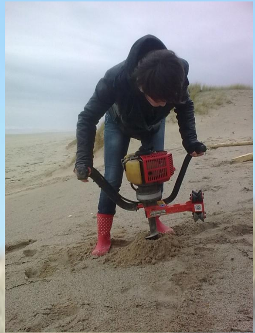
Première étape : creusement de trous, à l'aide de tarières, pour y enfoncer solidement les poteaux. Ils devront résister à la houle, au vent mais aussi, si possible, aux tempêtes.
