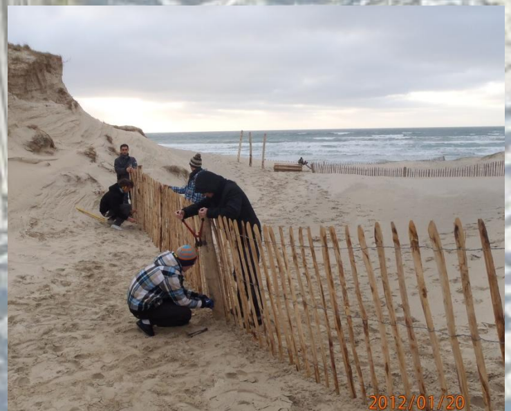
Troisième étape : la pose des ganivelles entre les poteaux. Les piétons ne pourront plus s'aventurer dans la brèche du cordon dunaire.
