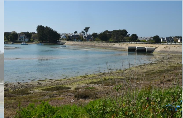
Le pont-digue, source d'envasement et d'ensablement
